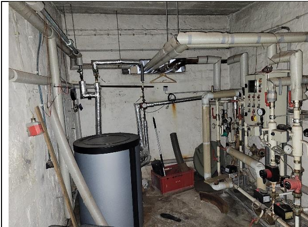
Heizungsraum (Fernwärme), Rohrisolierungen aus: neuem PE-Schaum, Mineralwolle, Glaswolle mit Gipsummantelung, Rohrleitungsflansche mit Asbestdichtung
