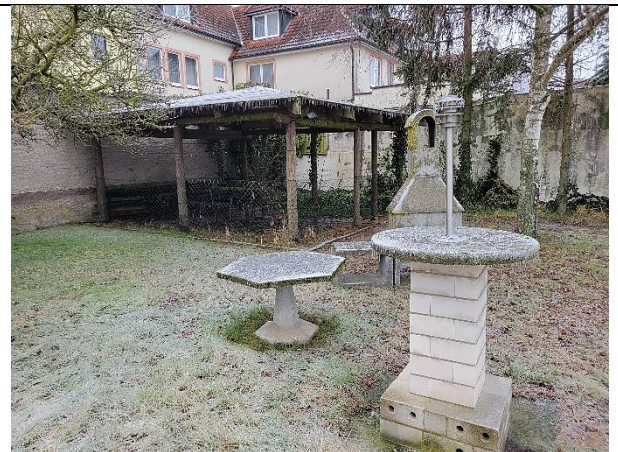
Überdachung: Holzständer und -lattung ohne Dachpappe, Betonpflastersteine
