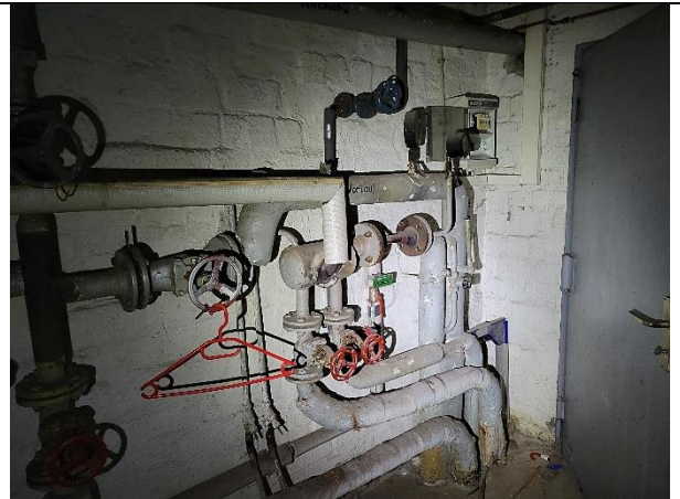
Heizungsraum (Fernwärme), Rohrisolierungen aus: neuem PE-Schaum, Mineralwolle, Glaswolle mit Gipsummantelung, Rohrleitungsflansche mit Asbestdichtung
