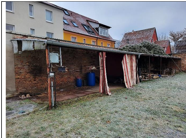
Überdachung: Metallständer, Wellplatten aus Kunststoff, Betonplatten
